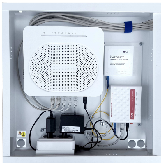
Pav.2. Galinio abonentų ryšių mazgo dėžė RMD-2VT su įranga
